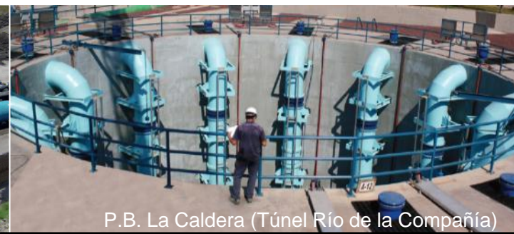
3ª Línea del Sistema Cutzamala
