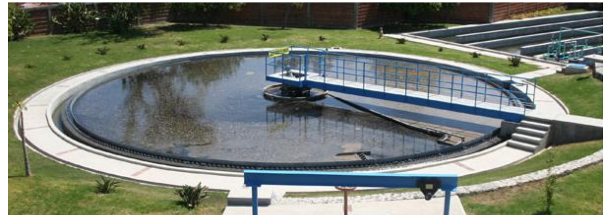
Sedimentador secundario circular
