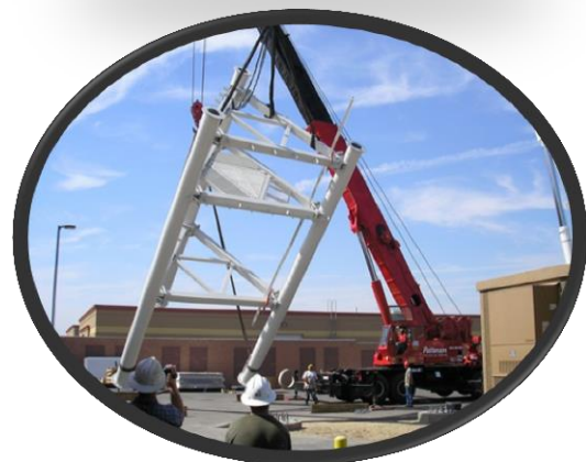
OPERACIÓN DE LA GRÚA MÓVIL EN BASE A NORMA ISO-15513-2000
