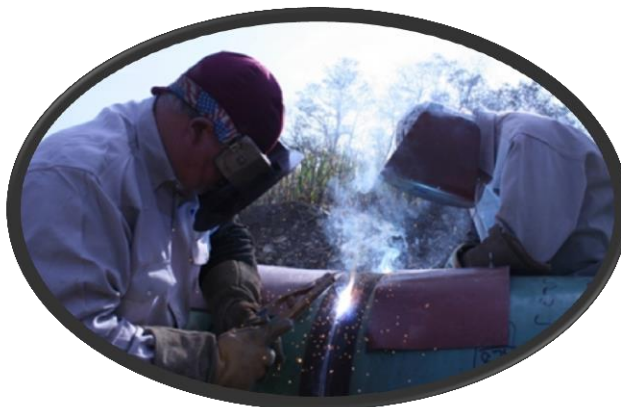
SOLDADURA DE TUBERÍA CON PROCESO SMAW
