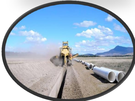
OPERACIÓN DE LA ZANJADORA PARA UN TERRENO ESPECÍFICO CON ANÁLISIS DE RENDIMIENTO
