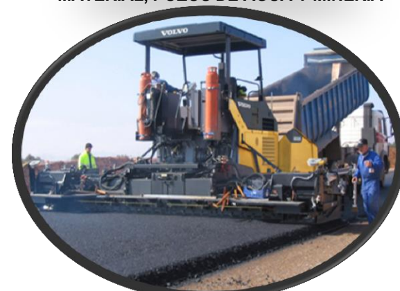
FORMACION DE OPERADORES EN LA MÁQUINA OPERACIÓN PAVIMENTADORA
