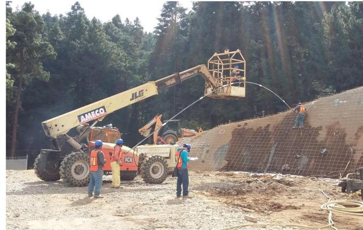
COLOCACIÓN DE ANCLAS PASIVAS DE 15m DE LONGITUD
