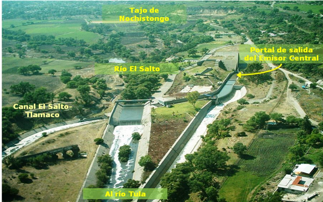
Figura 4 Destino de las aguas residuales del Valle de México
