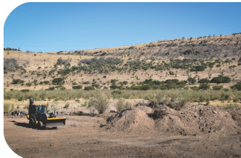
Desazolve y limpieza de la Presa del Hielo, Durango.
