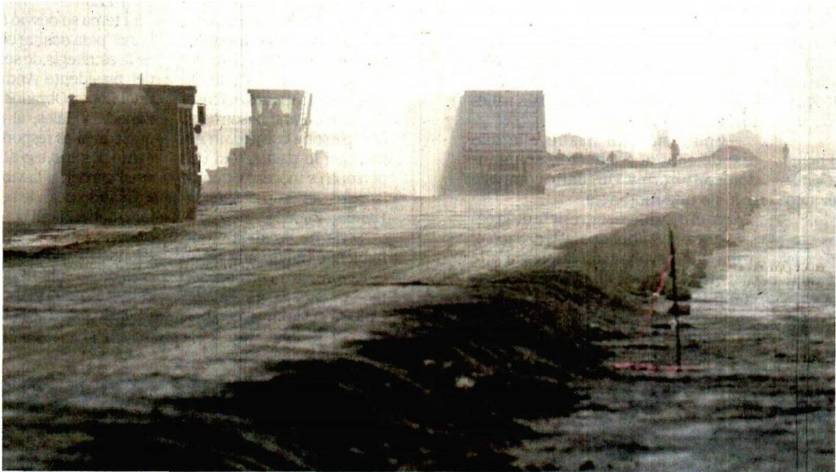
**La pista 1, que tiene una longitud de 4.5 kilómetros, de la que se hizo una parte del tendido, será de concreto hidráulico de alta resistencia para el soporte de las aeronaves.**
