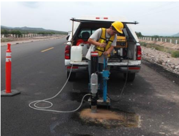
Extracción de núcleos para verificación de espesores y ensaye en laboratorio
