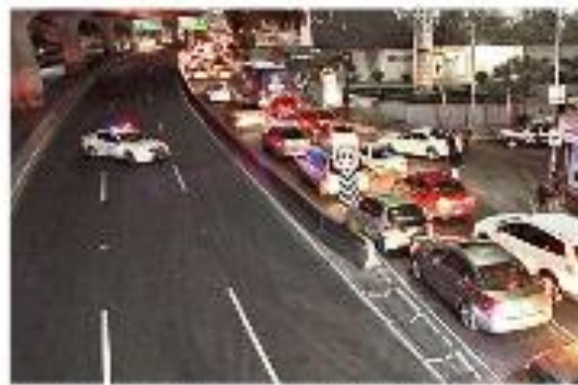
La tubería dañada obligó a cerrar los carriles centrales.
