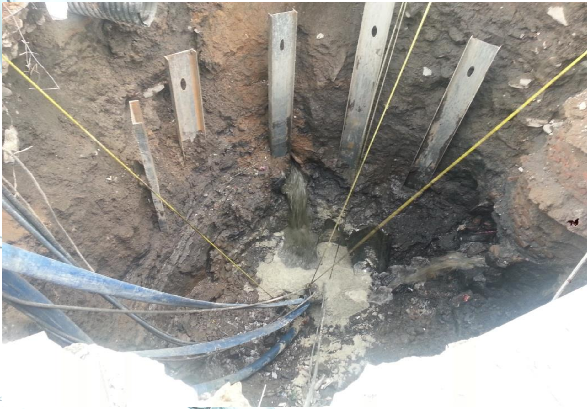
Excavación inicial para localizar el colector semiprofundo 5 de Mayo
