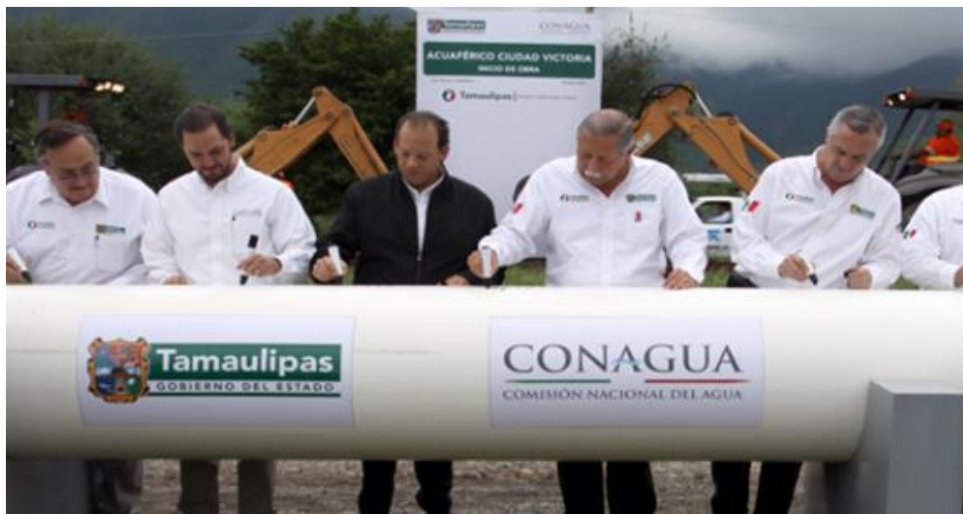
Inicio de construcción del Acuaférico (octubre, 2014)
