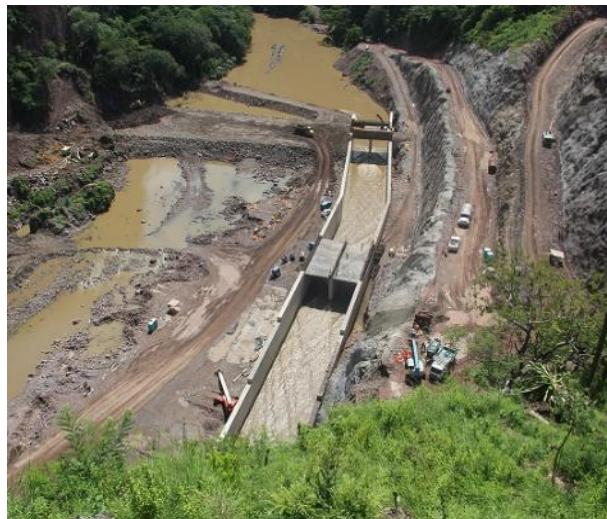
Presa "El Purgatorio"
