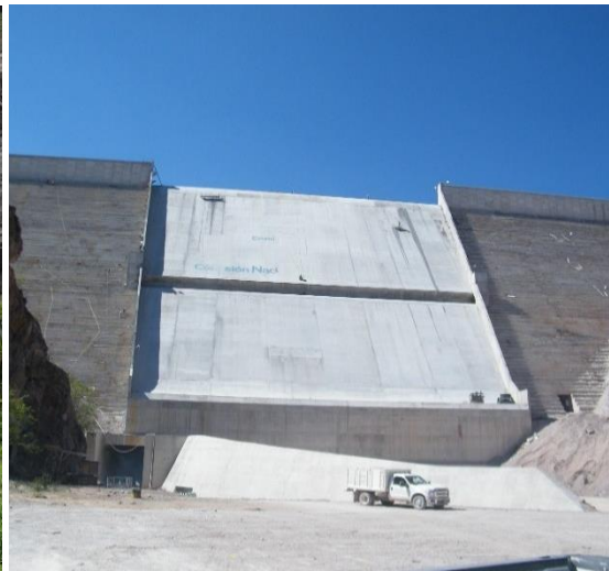
Presa "El Realito"
