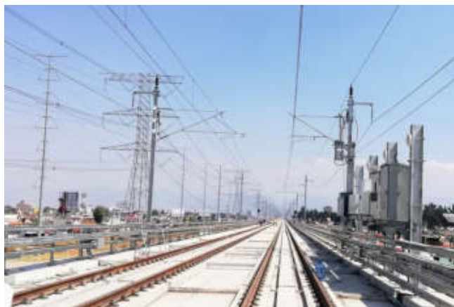
Tramo I: Vía y catenaria (Tren Interurbano México–Toluca)
