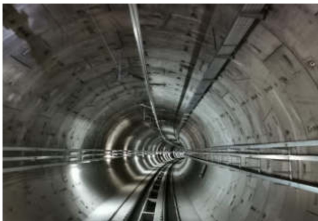
Tramo II: Túnel, : Vía y catenaria (Tren Interurbano México–Toluca)
