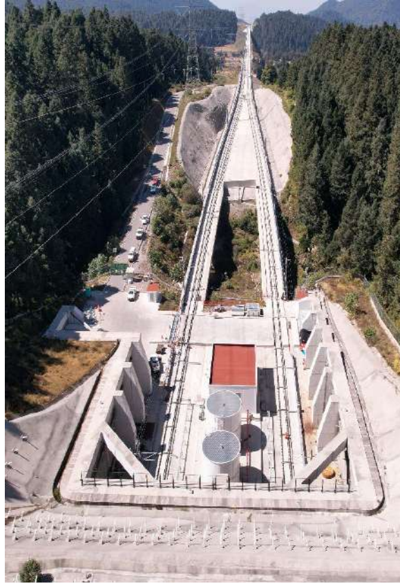
Portal Toluca y Viaducto en la Marquesa del Tren Interurbano México-Toluca
