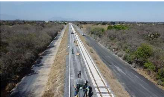
Libramiento a Monterrey
