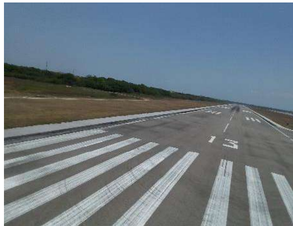
Rehabilitación de pistas. aeropuerto Ciudad del Carmen.
