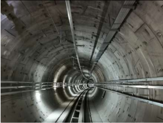
Bi-Túnel del Tren Interurbano México-Toluca
