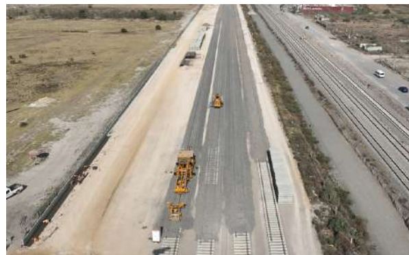
Ampliación del Tren Suburbano de Lechería al AIFA
